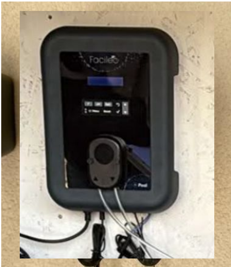
Pompe doseuse ph Entre 7,2 et 7,3 + appareil pour SEL
